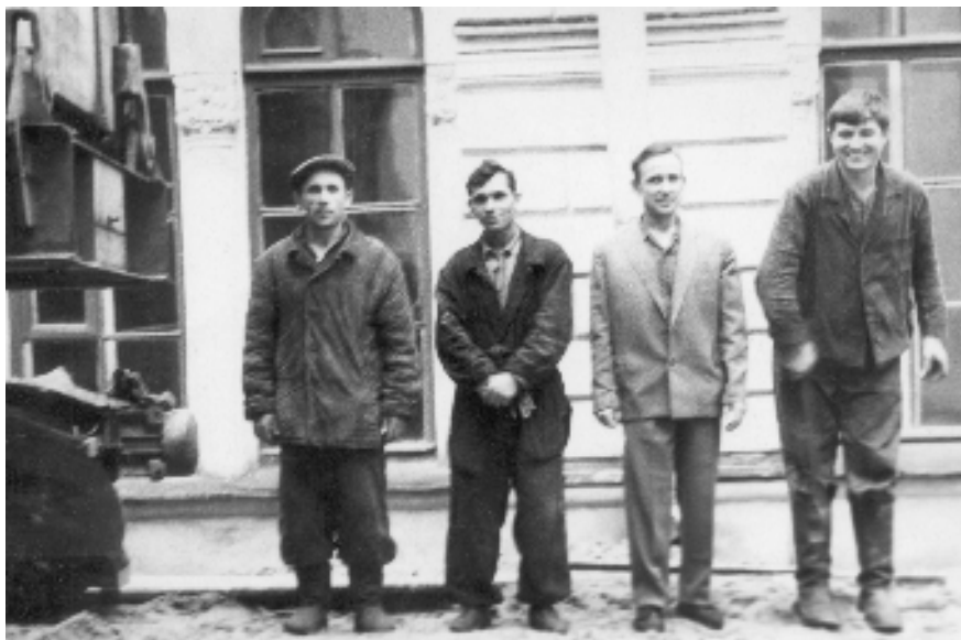
Бригада слесарей-монтажников башенного крана КБ-60: машинист крана А. Высоков, электрослесарь В. Зубков, механик А. Гусев и слесарь А. Асаул
