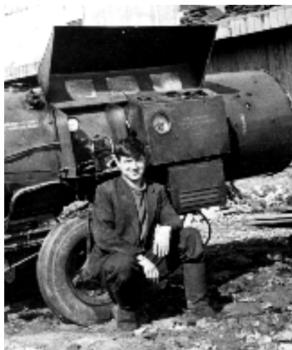
Строительство Речного вокзала. А. Асаул возле установки ВПТ-300. Ленинград. 1970 г.
