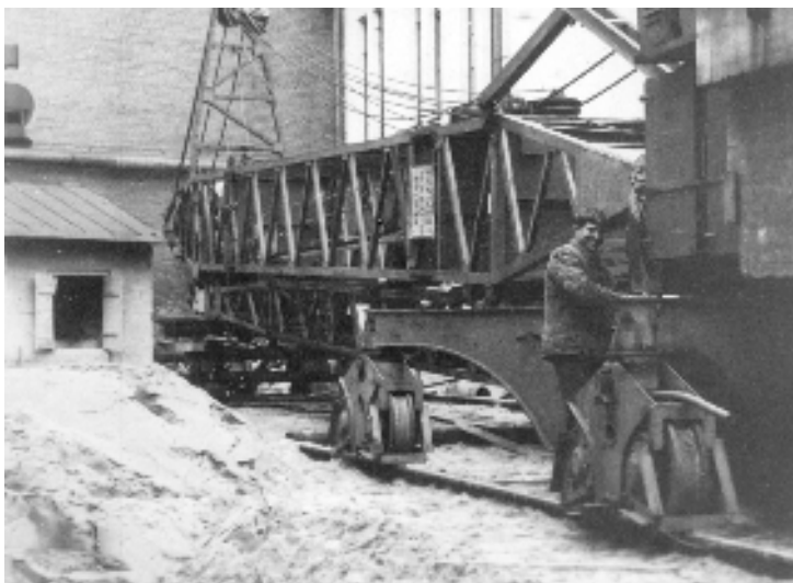
ЛИИЖТ. Монтаж башенного крана КБ-60 возле корпуса механической лаборатории им. Н. А. Белелюбского. Слесарь А. Асаул
